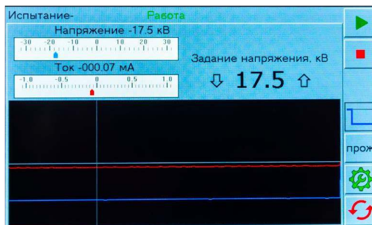
Рис. 12 режим работы генератора - «Испытание -»
